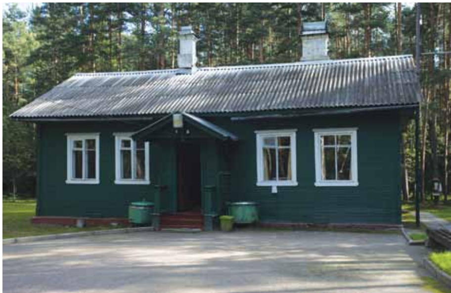
Das ehemalige Wachhaus. Aufnahme 2011
