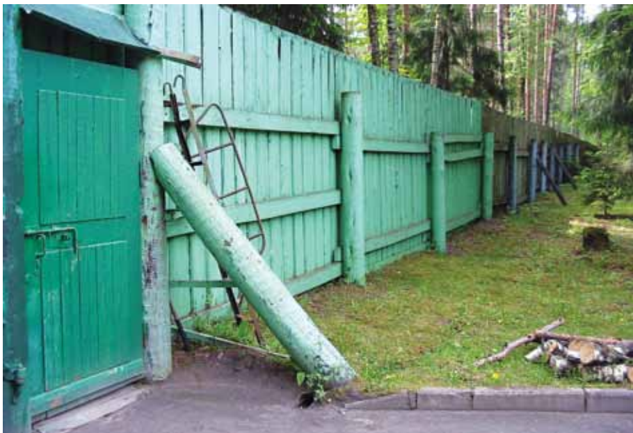
Porte et palissade (vue de l'intérieur). 2008
